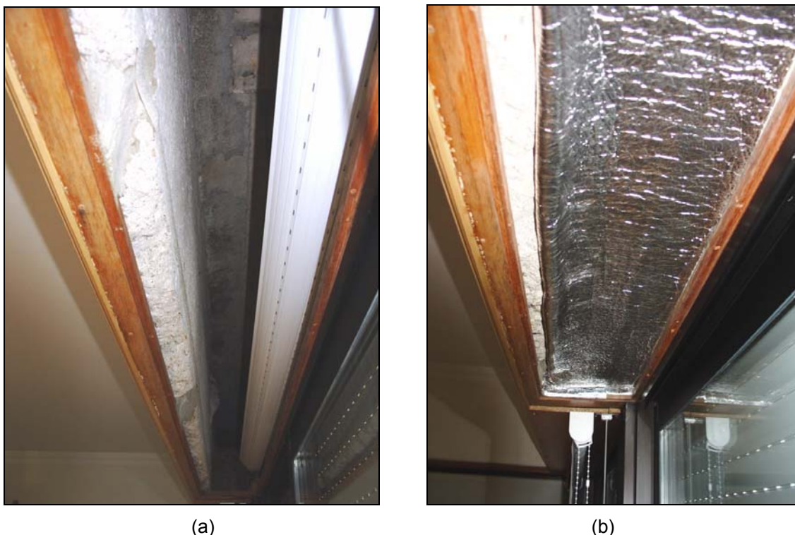
Fig. 2 – Imagem de uma das caixas de estores: (a) antes e (b) após a aplicação da tela Aldageed .
